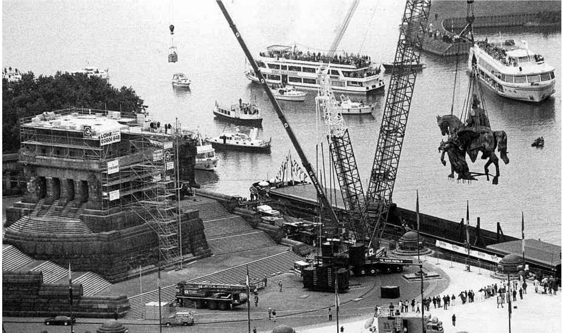
Am 2. September 1993 wird das rekonstruierte Reiterstandbild Kaiser Wilhelms I. auf seinen Sockel am Deutschen Eck in Koblenz gesetzt. Das Monumentalwerk aus circa 40 Tonnen Bronze entstand in der Düsseldorfer Kunstgießerei von Raimund Kittl.
